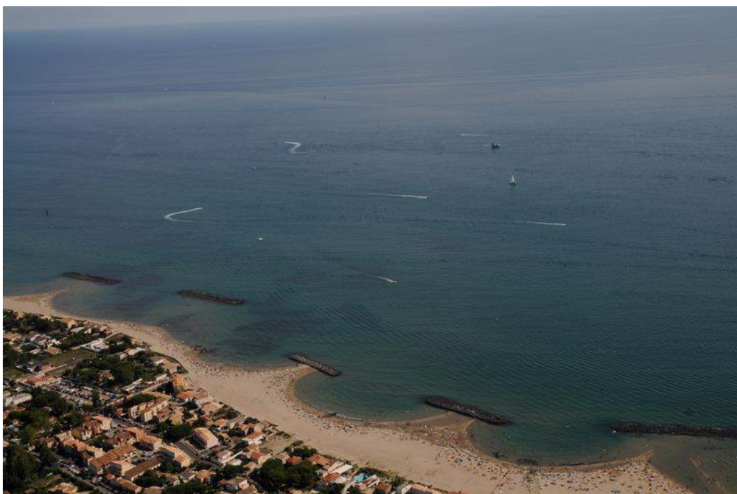
Figure 5 : Ouvrages de défense contre l'érosion littorale de type « brise-lames ».
